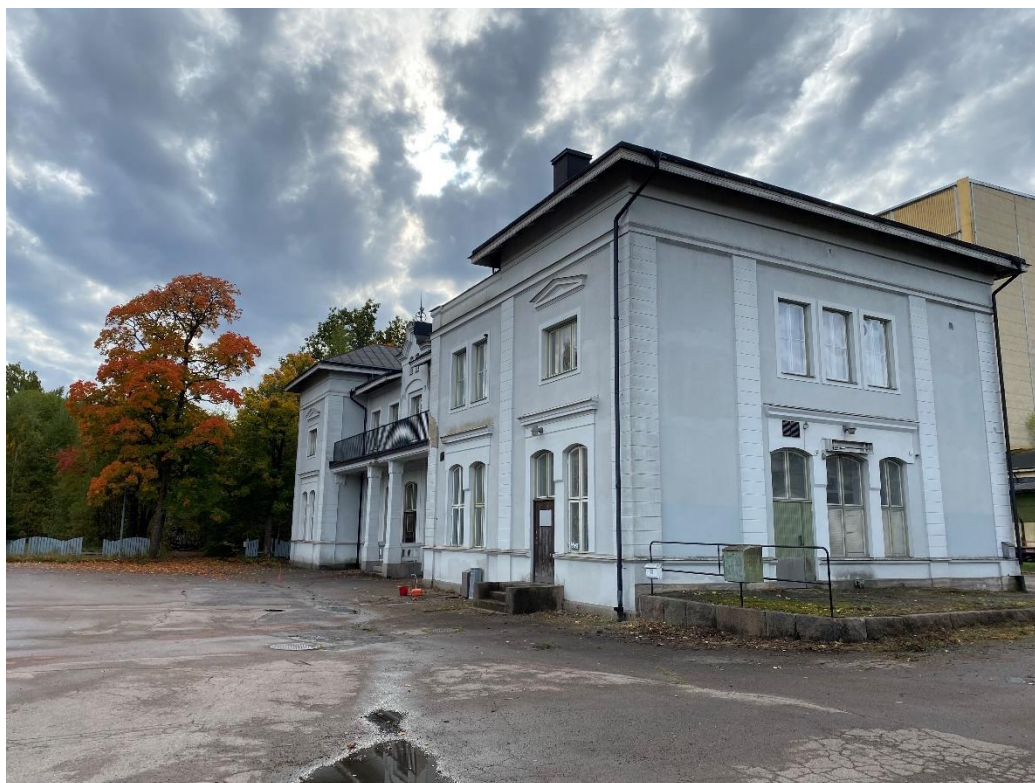
Figur 5. Provpunkt 22TY06P samt stationshuset.
