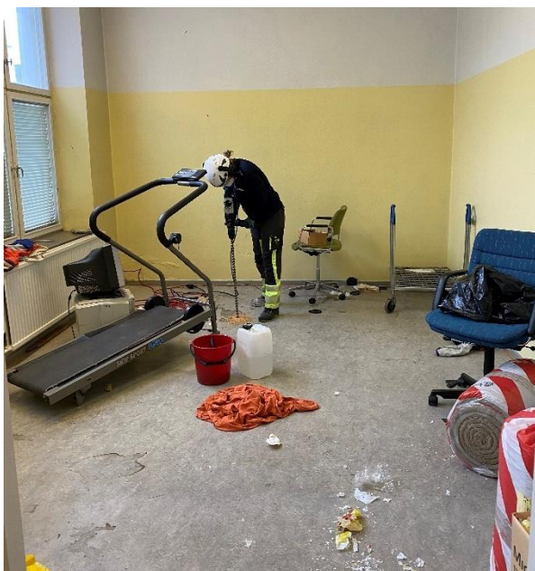
Figur 2. Borrningsförsök genom betongplattan i kontorsrum.
