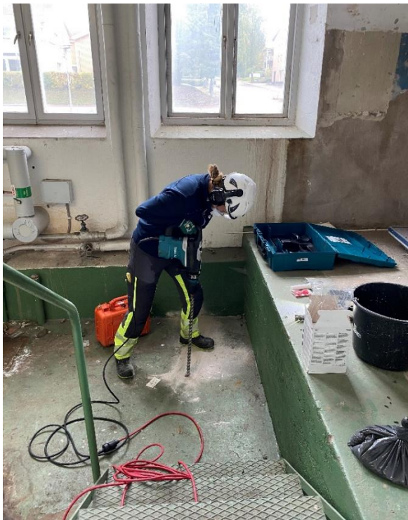
Figur 1. Borrningsförsök genom betongplattan i pannrum.
