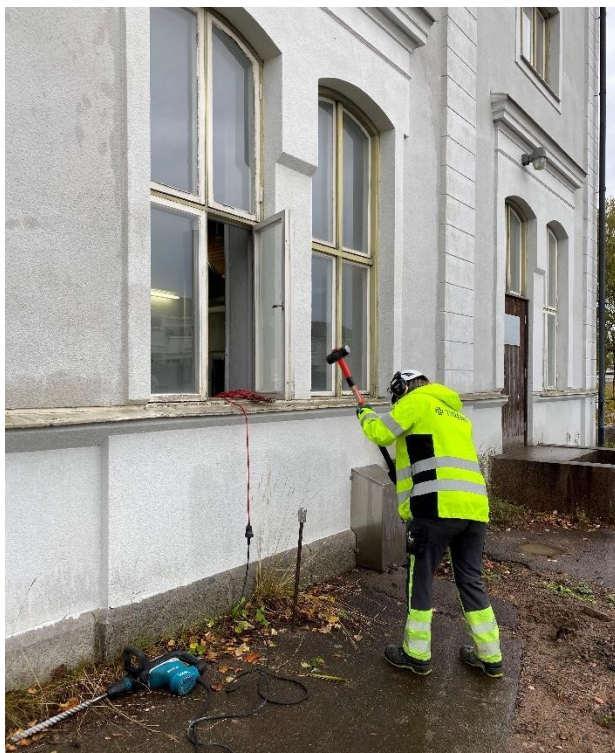
Figur 3. Installation av porluftsspjut med hjälp av slägga för att få ner spjuttet till rätt nivå under markytan (cirka 0,5 meter under markytan). Provpunkt 22TY06P.
