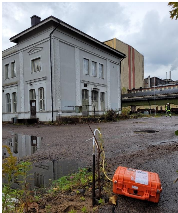
Figur 8. Provpunkt 22TY04P och stationshuset.
