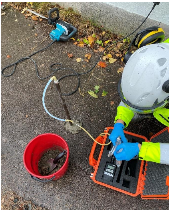
Figur 4. Installation av slang kopplad till luftpumpen, samt tätning med bentonit kring markytan för att undvika inläckage av atmosfärisk luft. Provpunkt 22TY06P.
