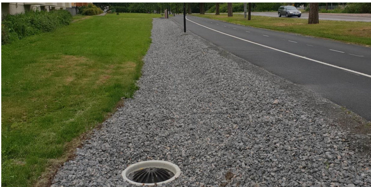
Figur 21. Exempelbild på ett makadamdike utmed en cykelväg i östra Göteborg. Foto: Dämmningsverket 2018.
