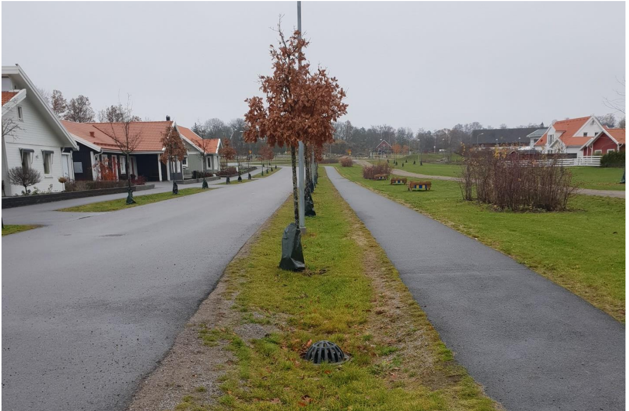
Figur 23. Exempel på ett grunt svackdike med kupolsil i nya Ullstämmaområdet i Linköping. Foto: Dämmningsverket 2018.
