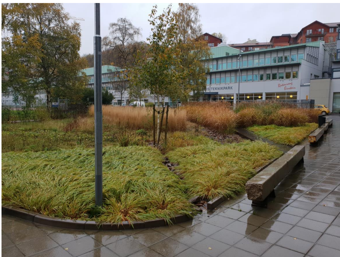
Figur 25. Regnbädd vid Chalmers i Göteborg. Bild: Dämmningsverket 2018.
