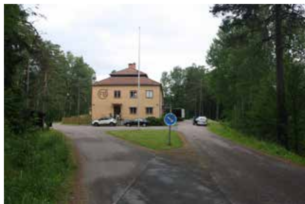
Filipstadstidningens hus, bostäder, kontor och förskola.
