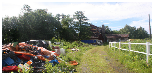
Vy sett från Smedjan mot Storbroyttan
