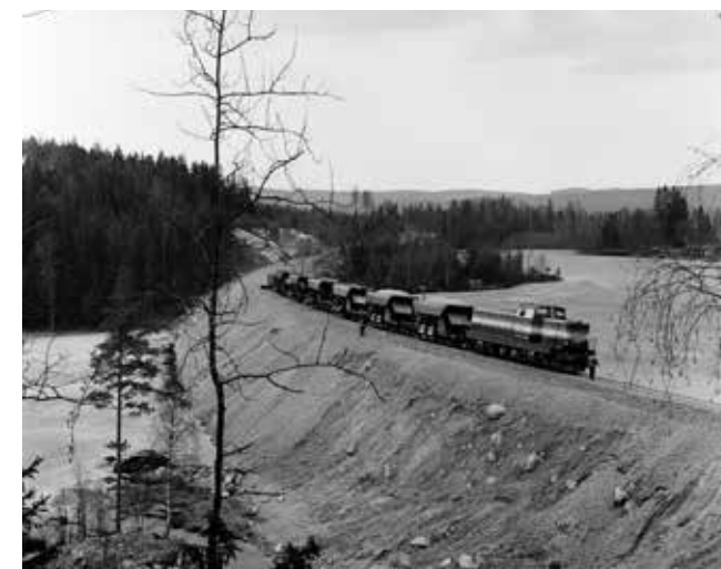
Till höger: Ett arbetståg med makadamvagnar håller på att färdigställa Inlandsbanans nya dragning mellan Filipstad och Persberg 1964. Loket heter T43 224 och levererades till SJ 1962. 2005 såldes det till TÅGAB i Kristinehamn som ändrade namnet till T43 111. Foto Järnvägsmuseet.
