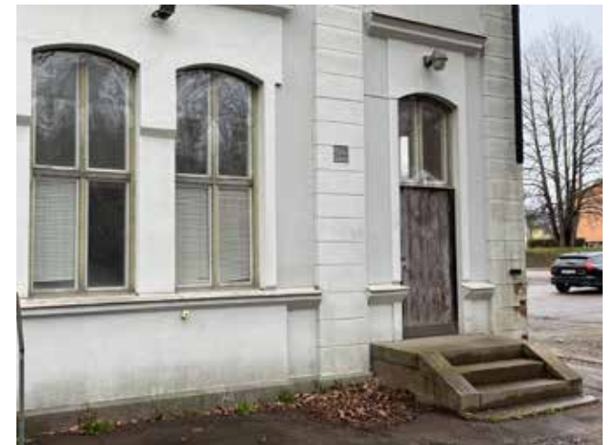
Södra fasaden. Överst: Foto taget från den igenväxta granntomten. Nederst: Fönster, stentrappa och entrédörr till bostadvåningens trapphus.
