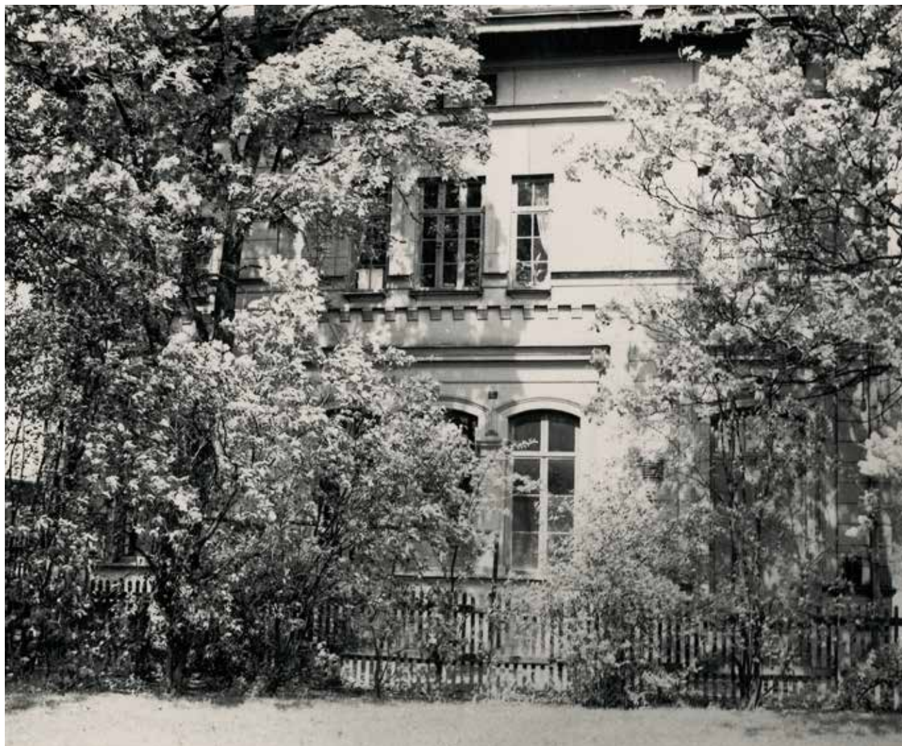
Södra gaveln 1935. Foto: Järnvägsmuseet.
