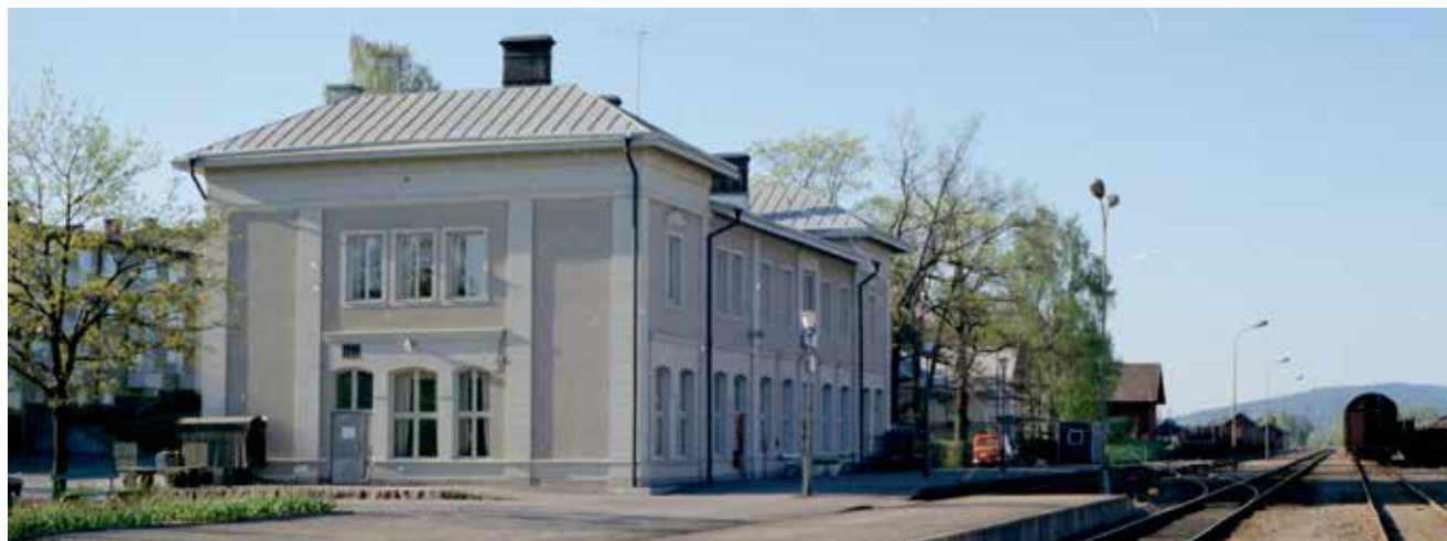
Stationshuset från norr mot söder 1964 precis efter genomförd fasadrenovering. Foto: Järnvägsmuseet.
