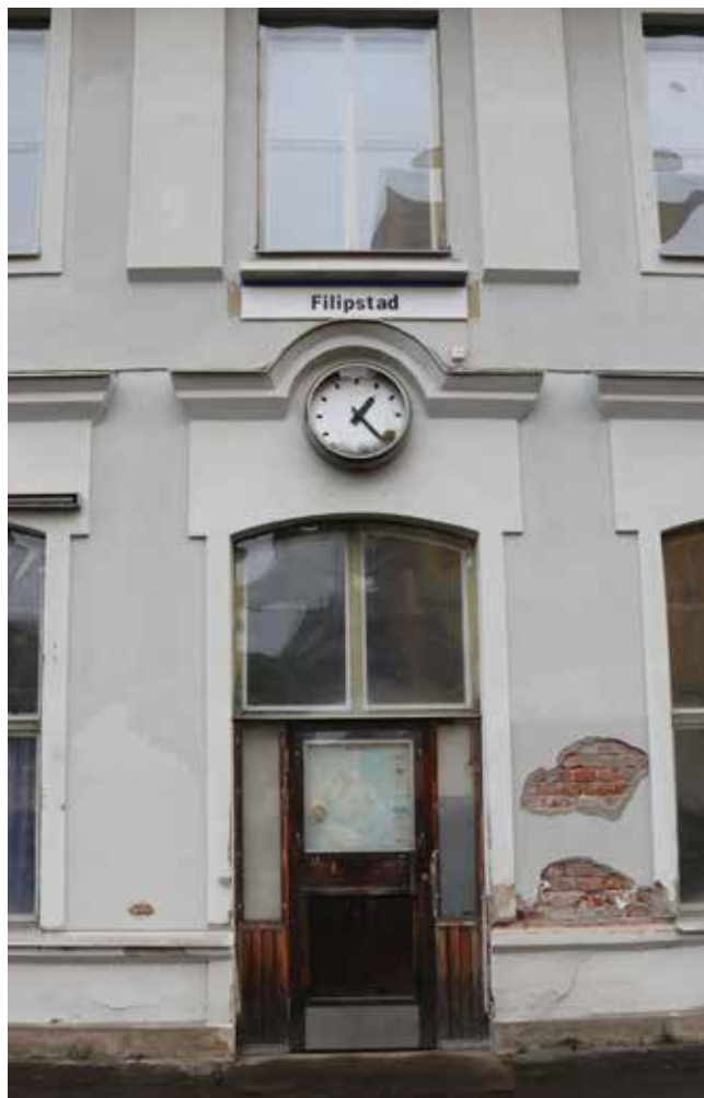
Västra fasaden. Entrén till väntsalen från spårsidan. Ovanför stationsklockan och den rundade våningsgesimsen syns den utskjutande fönsteromfattningen som markerar entrédörren.
