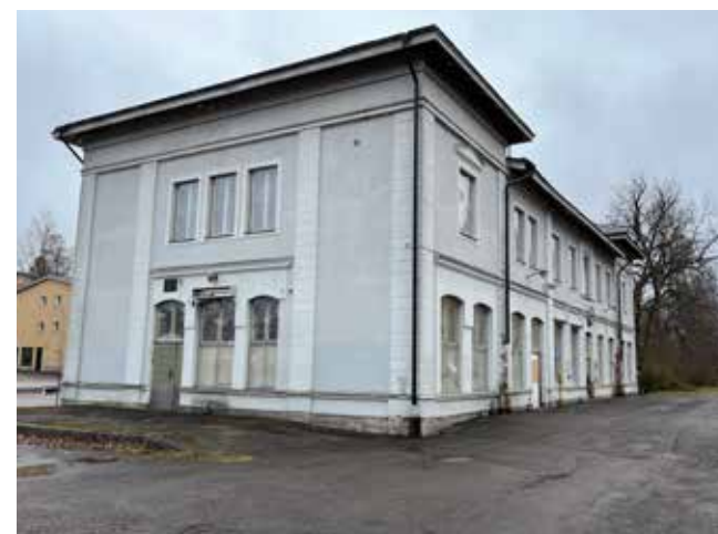
Överst: Västra fasaden mot söder. Underst: Norra och västra fasaden. Framför fönstren sitter plastskivor som hindrar vandalisering. Framför gaveln skymtar den stensatta lastbryggan.
