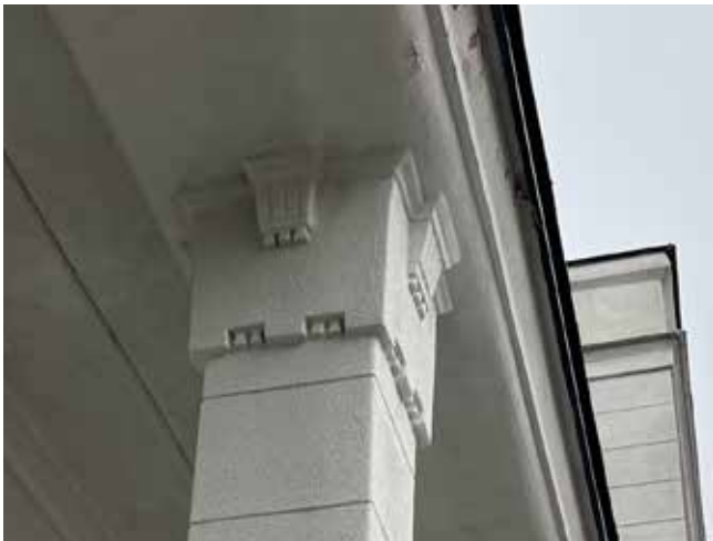
Detaljbilder från Östra fasaden. Överst: Frontespisen ovanför entrén kröns av ett bevingat järnvägseblem. Nederst: Dekorativ puts på en av pelarna vid entrén som bär upp balkongen.
