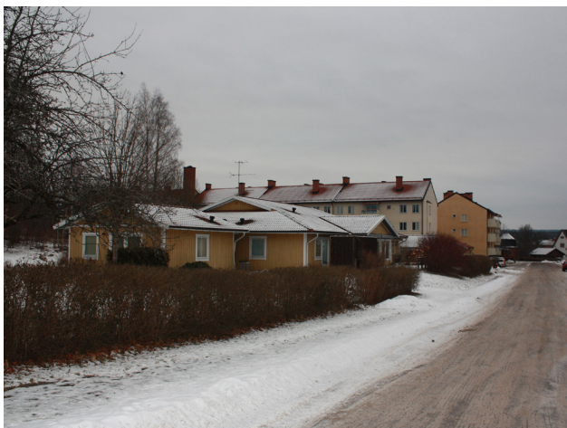
Ovan: Befintligt enplanshus med LSS-boende sett från Klippgatan
