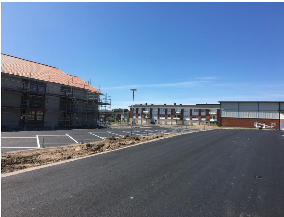
... och praktisk in / utpassering fungerar. P-platser för anställda på sidan byggnaden, inte framför entrén.
